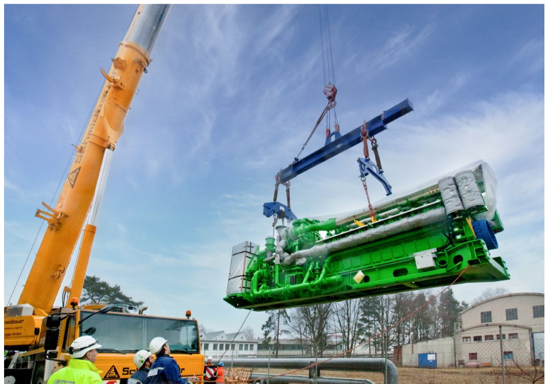
Einbringung des BHKW-Moduls mittels Autokran
