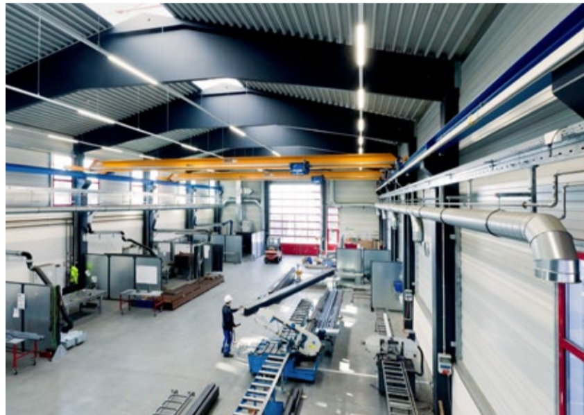
Stahlbaufertigung in Pilgramsberg
